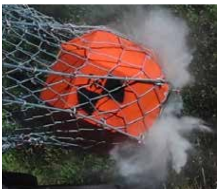
Barrières de protection contre les éboulements
