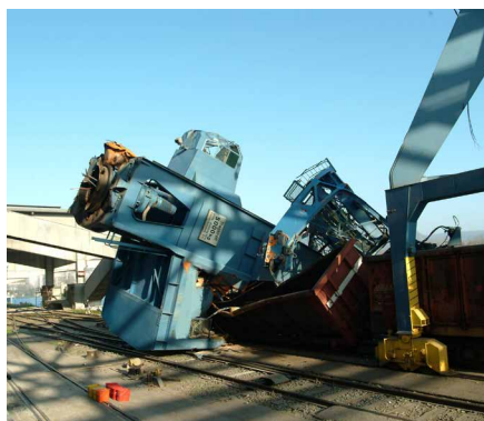
Écroulement d'une grue portuaire suite à la corrosion destructrice d'une colonne de tourelle
