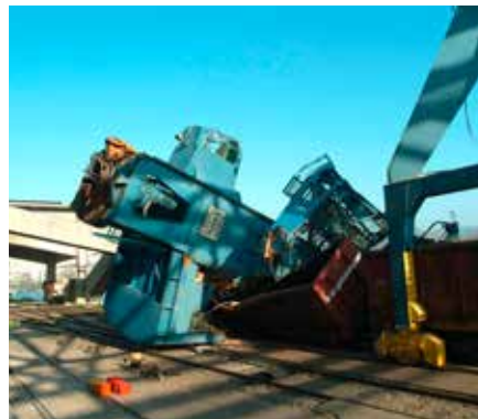
Abgebrochener Hafenkran nach Durchrostung der Turmsäule
